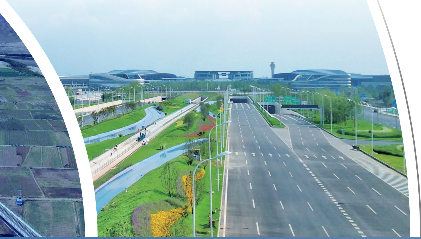
成都天府国际机场 北垂滑隧道
